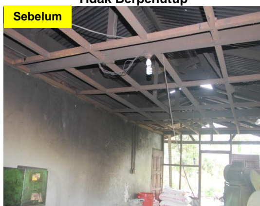
Gambar 3.1 Lampu Di Bahagian Pemprosesan Tidak Berpenutup
