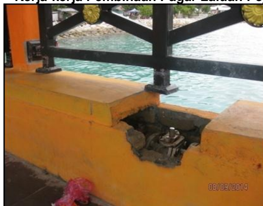
Gambar 2.8 Kerja-kerja Pembinaan Pagar Laluan Pejalan Kaki Di Jeti Kampung Tidak Sempurna
