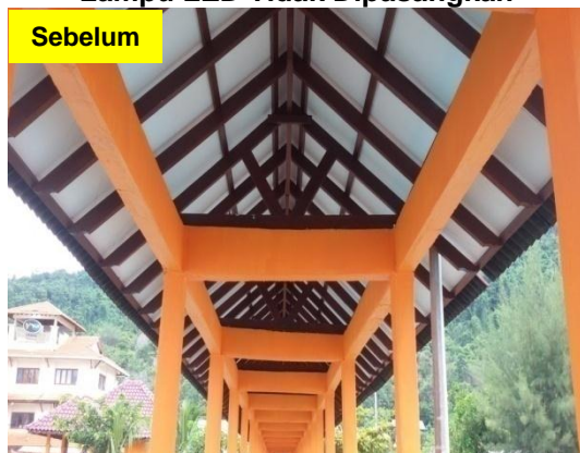
Gambar 2.6 Lampu LED Tidak Dipasangkan
